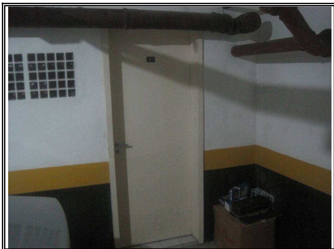
Foto nº 47: Vista do depósito (1º subsolo)
