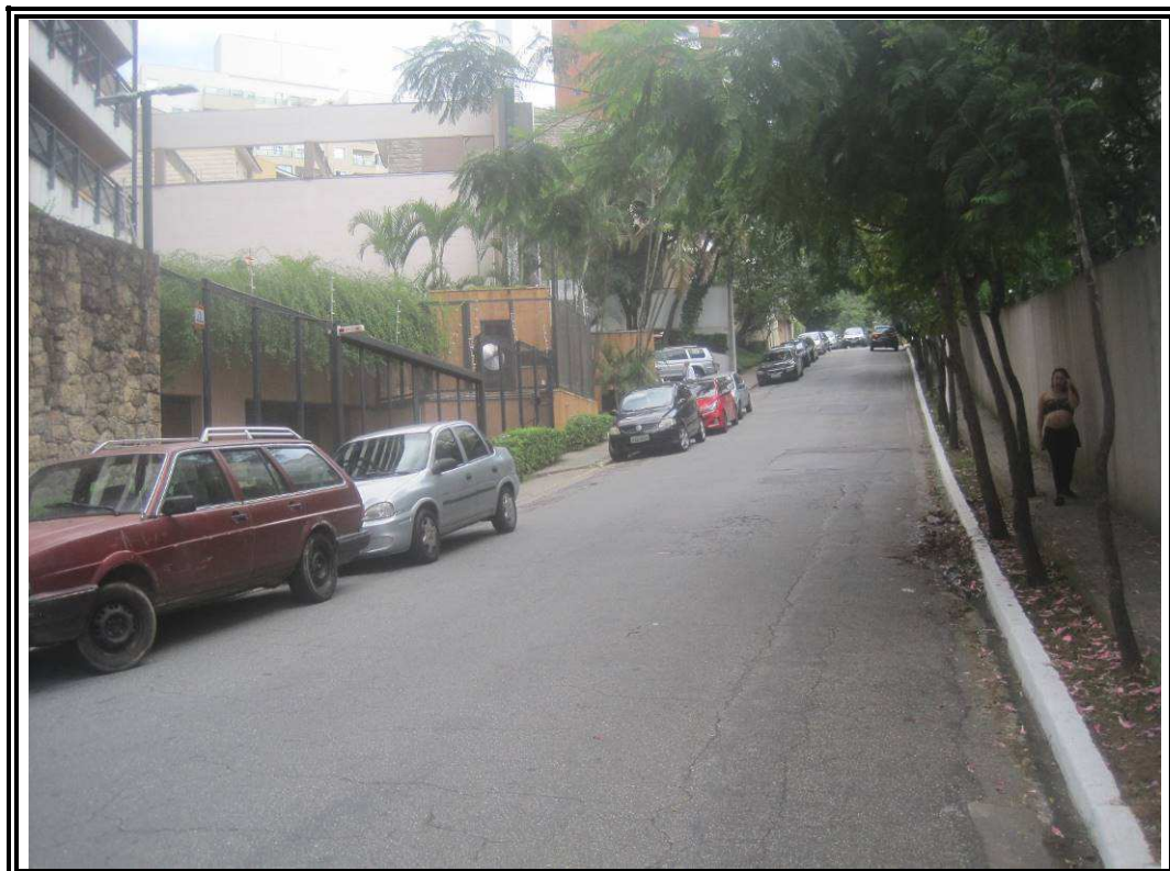
Foto nº 04: Vista geral da Rua Ascencional
