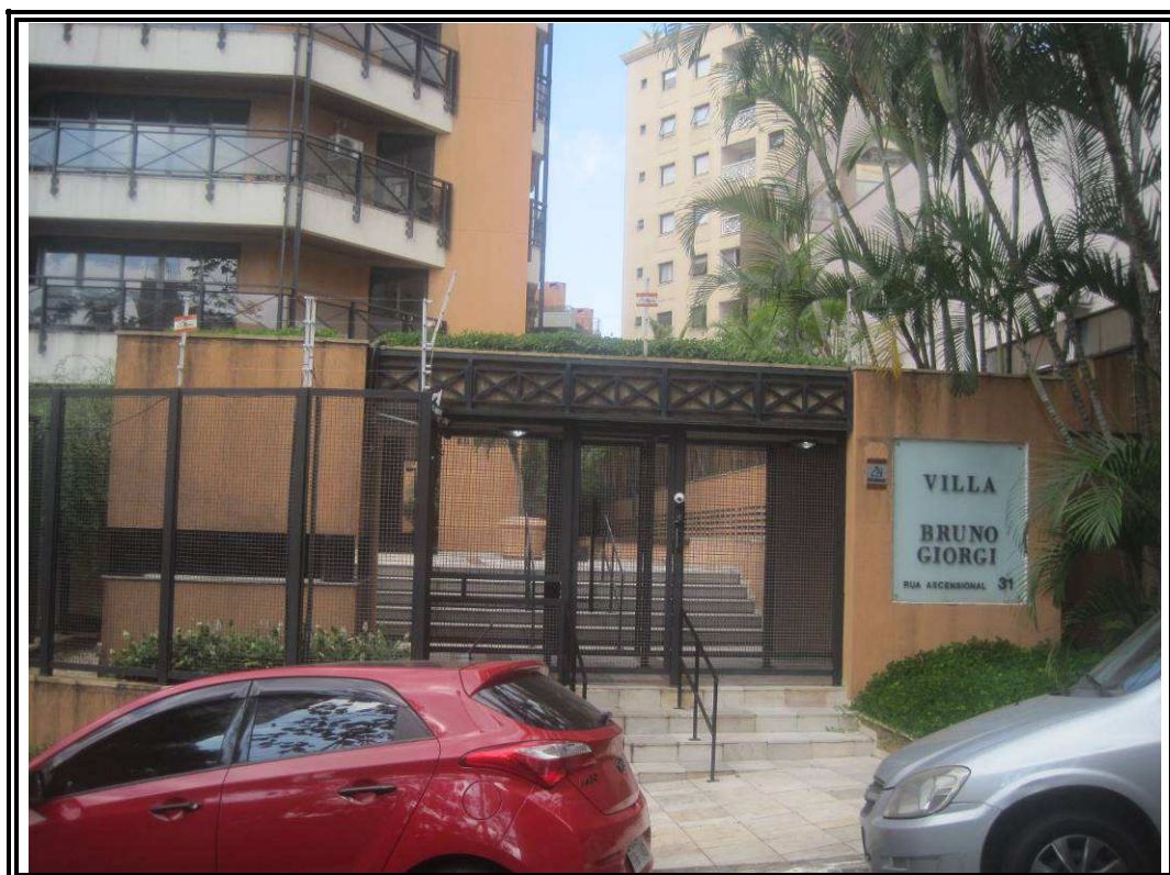
Foto nº 06: Vista da portaria de acesso ao Condomínio Villa Bruno Giorgi
