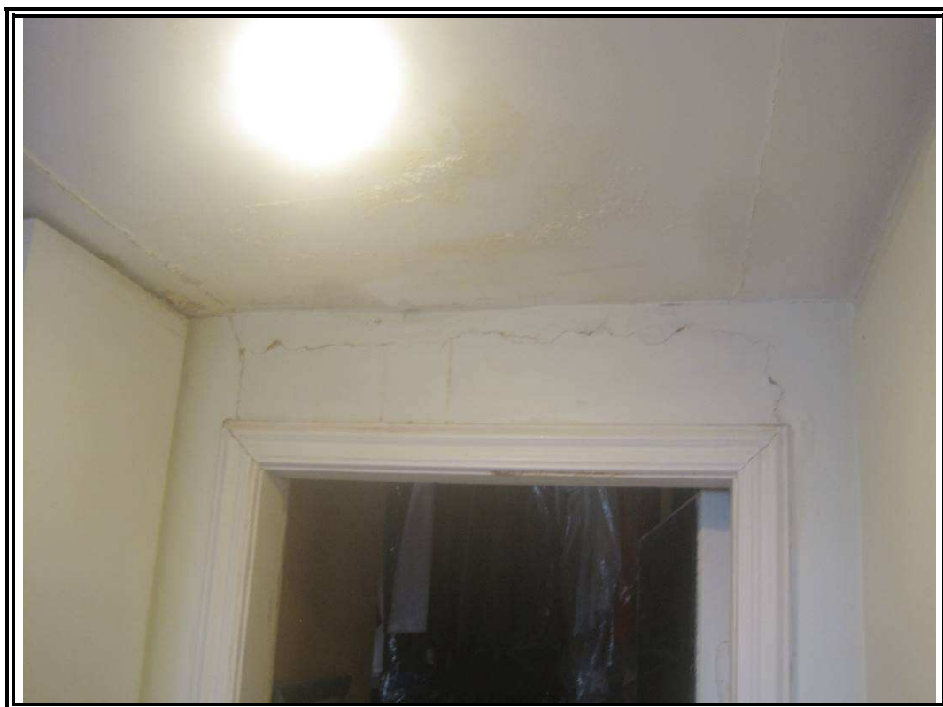
Fotos nº 17 e 18: Detalhe dos pontos de infiltração existentes no forro do dormitório 01 (suíte máster)
