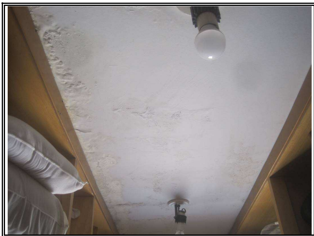
Fotos nº 22 e 23: Detalhe dos pontos de infiltração existentes no forro do closet (suíte máster)
