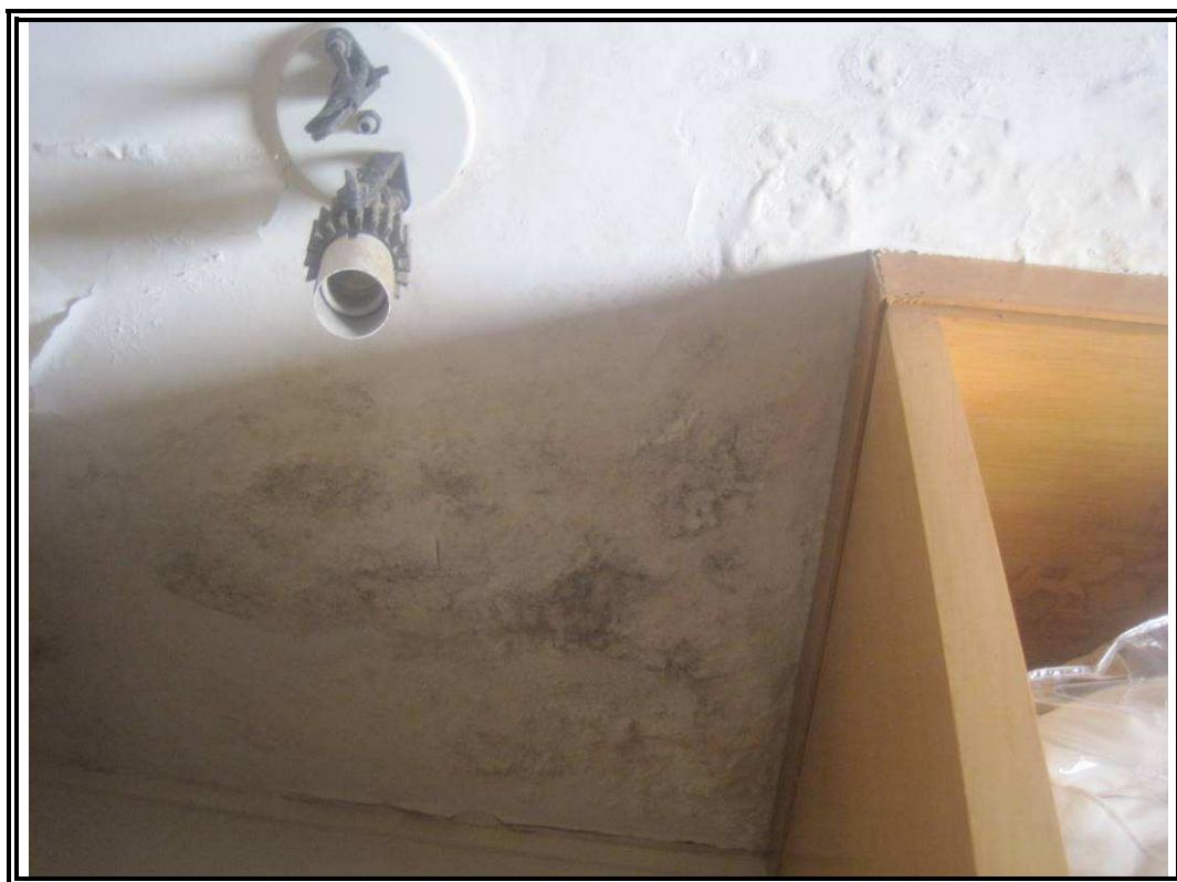
Fotos nº 22 e 23: Detalhe dos pontos de infiltração existentes no forro do closet (suíte máster)
