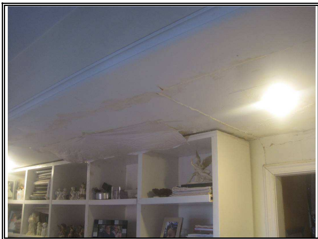
Fotos nº 17 e 18: Detalhe dos pontos de infiltração existentes no forro do dormitório 01 (suíte máster)
