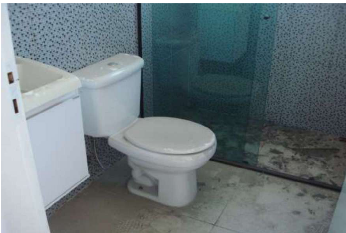
FOTO Nº 14 – Vista do banheiro social no apartamento paradigma.
