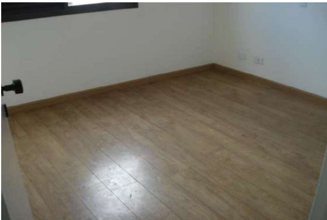
FOTO Nº 13 – Vista do terceiro dormitório no apartamento paradigma.
