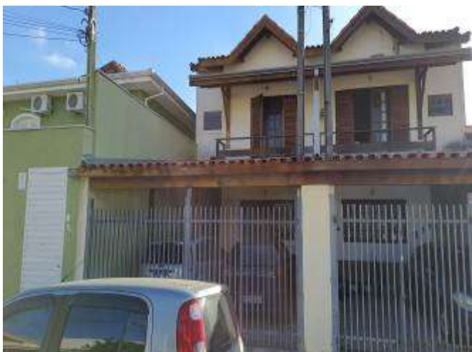
Foto 3 – Vista do imóvel ao lado nº 246 (geminada)
