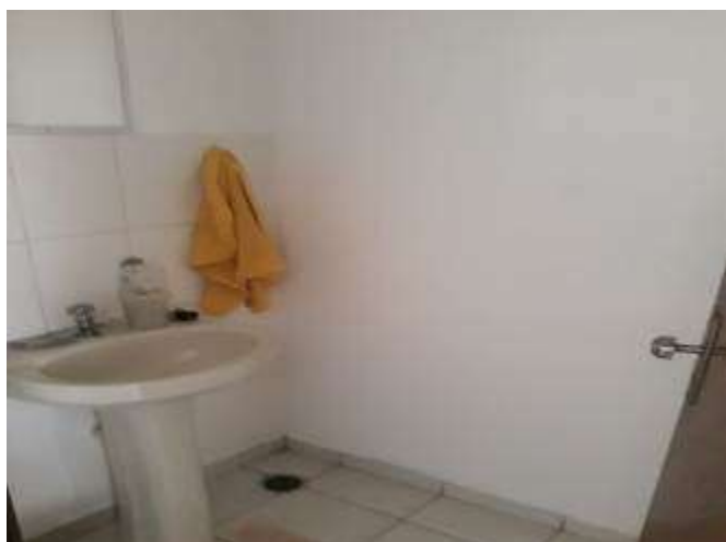
Foto 18 – Banheiro social (pavimento superior)
