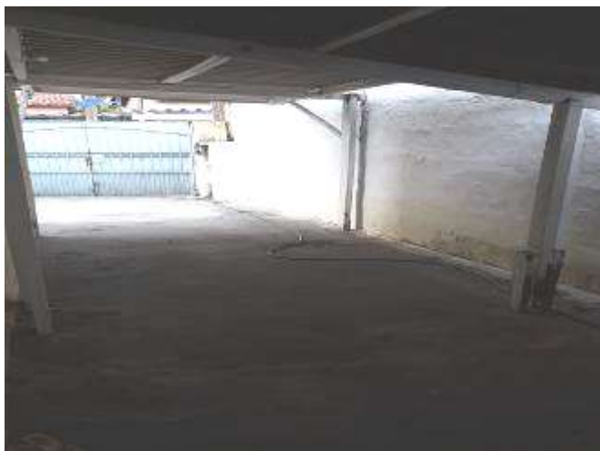
Foto 6 – Garagem coberta (abrigo desmontável)
