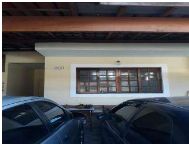
Foto 2 – Identificação do imóvel (nº 250/252)
