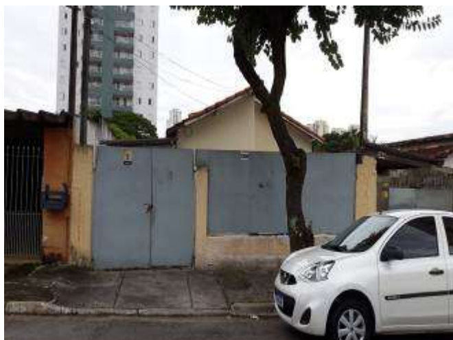
Foto 4 – Imóvel nº 286 (casa principal)
