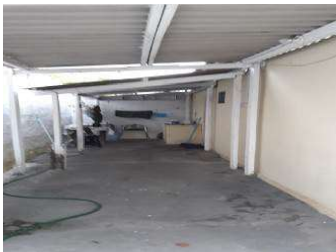
Foto 7 – Vista área de serviço (abrigo desmontável)
