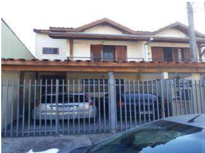
Foto 1 – Vista do imóvel
