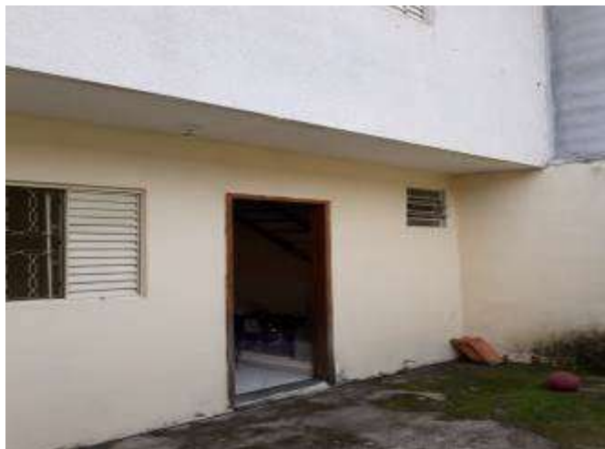
Foto 12 – Vista (pavimento inferior)
