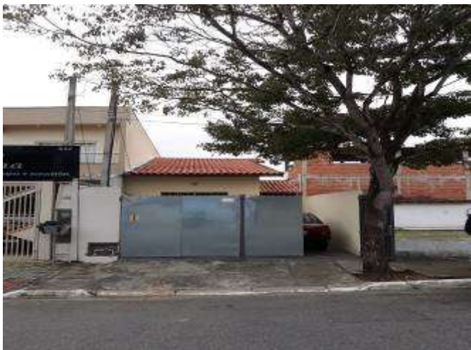
Foto 1 – Vista do imóvel
