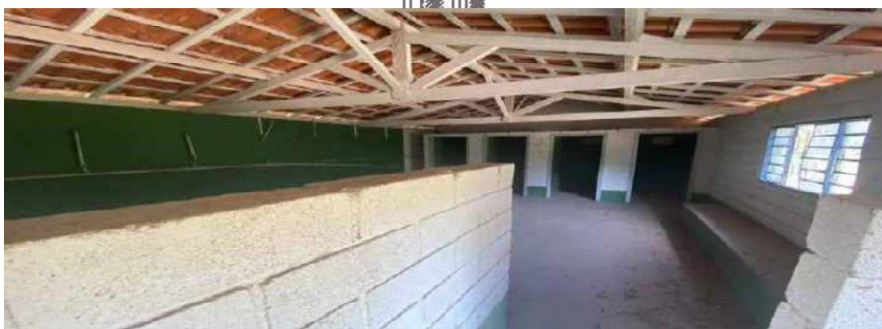
VISTA VESTIÁRIOS - CAMPO DE FUTEBOL 04
