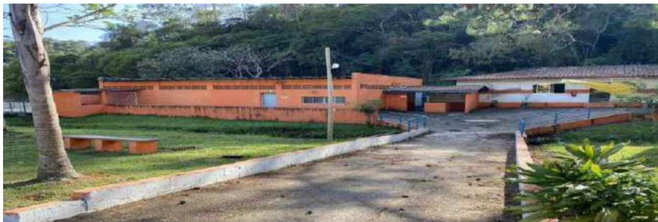
VISTA RESTAURANTE DA PISCINA/VESTIÁRIOS E BANHEIROS
