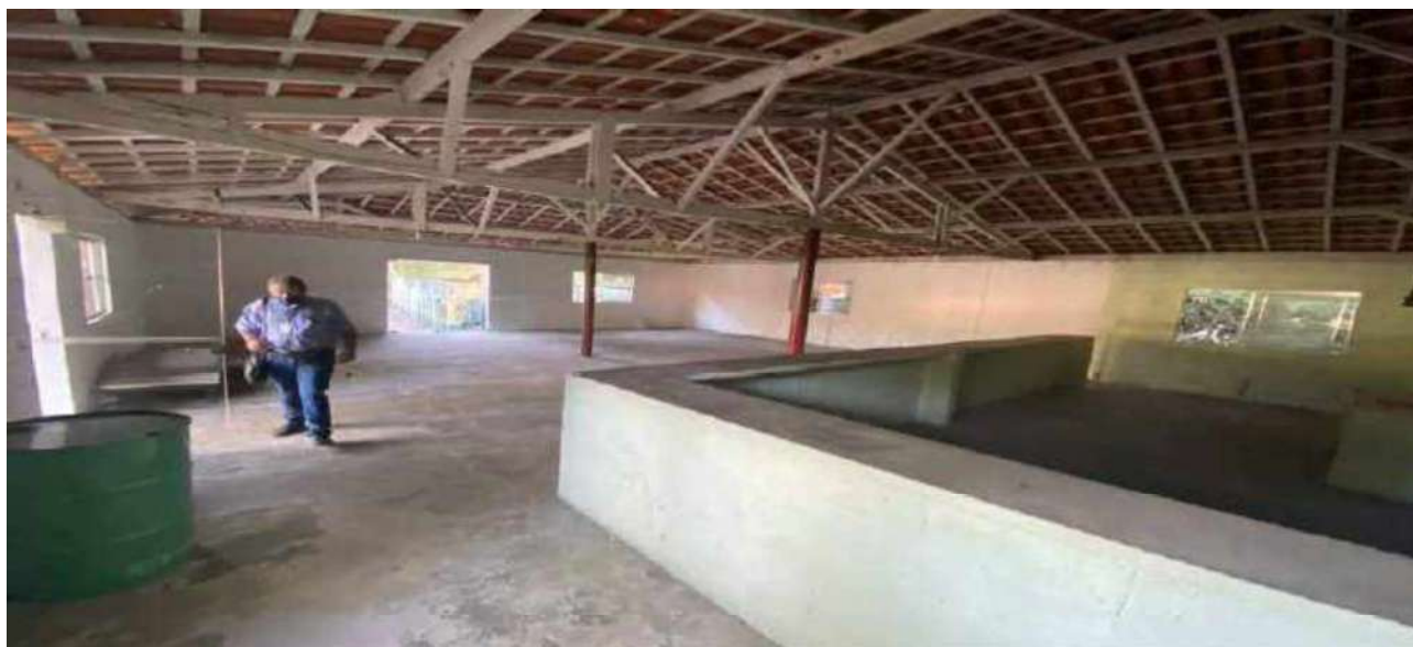
VISTA ANTIGO RESTAURANTE DA PISCINA
