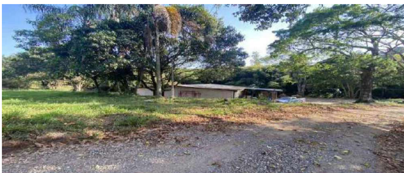
VISTA GALPÃO DE MARCENARIA
