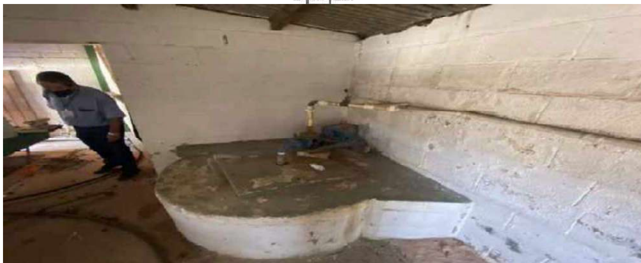
VISTAS POÇO ARTESIANO
