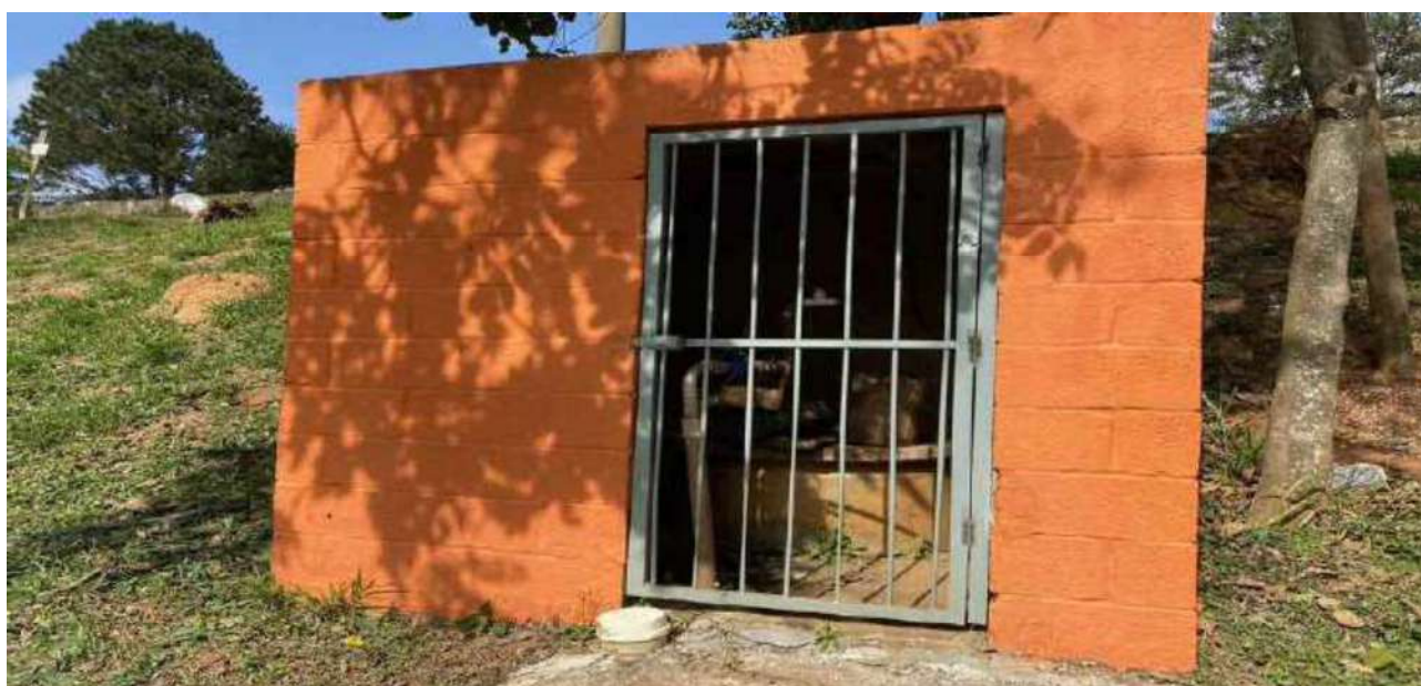
VISTA ABRIGO POÇO ARTESIANO
