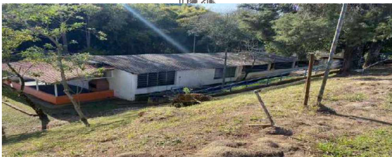
VISTA BOX PARA FESTAS E ABRIGO POÇO ARTESIANO
