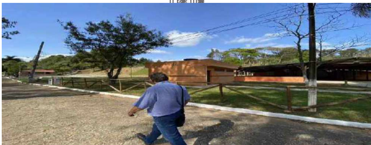
VISTA BANHEIRO E SALÃO DE FESTAS
