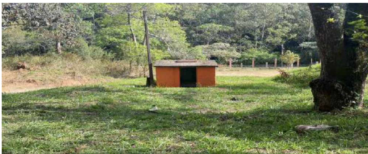
VISTA ABRIGO POÇO DESATIVADO
