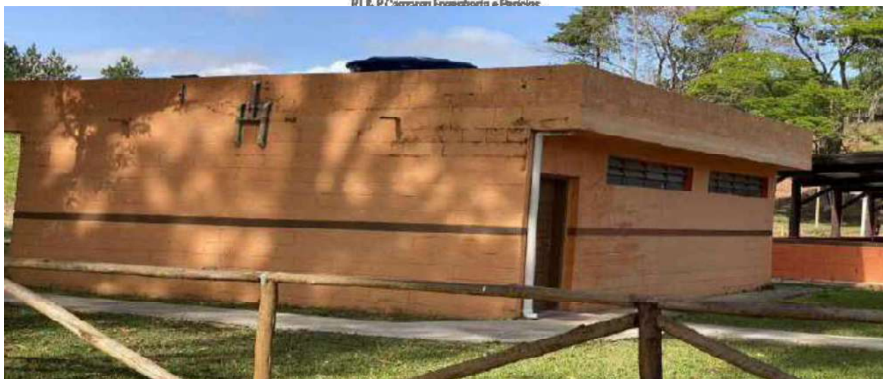
VISTA BANHEIROS SALÃO
