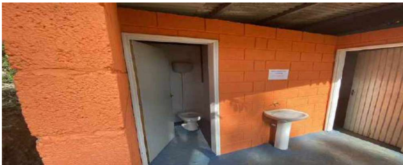
VISTA VESTIÁRIOS CAMPO DE FUTEBOL 04
