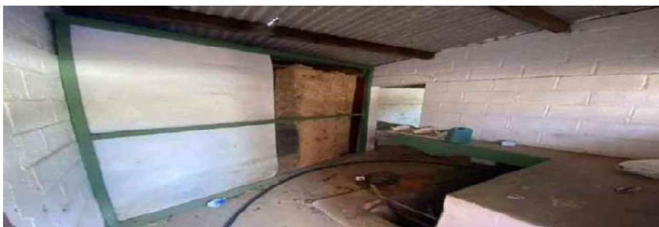
VISTAS CASA DE BOMBAS E POÇO ARTESIANO
