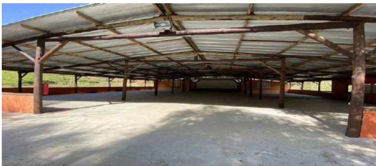
VISTAS NOVO SALÃO DE FESTAS COM COZINHA
