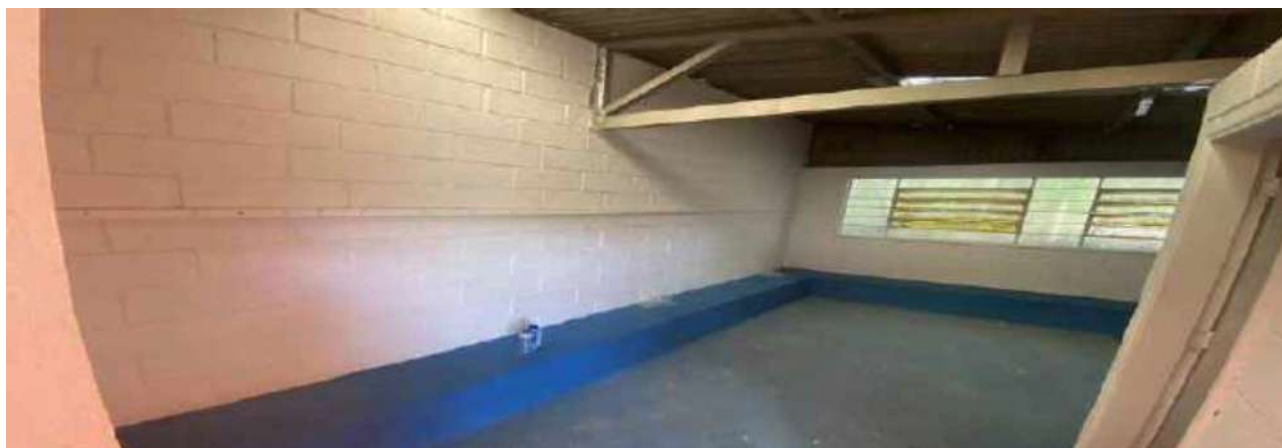
VISTA VESTIÁRIOS PRÓXIMA QUADRA
