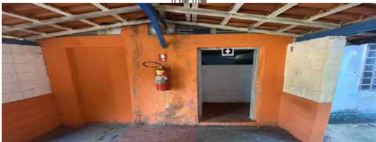
VISTA BANHEIROS ANTIGO RESTAURANTE
