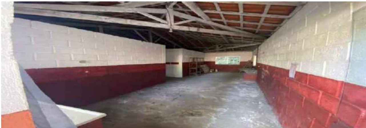
VISTA ANTIGO RESTAURANTE DA PISCINA
