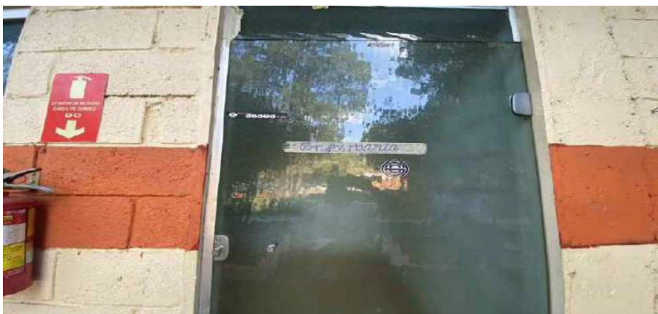
VISTA ENFERMARIA PISCINAS
