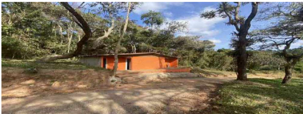
VISTA VESTIÁRIOS - CAMPO DE FUTEBOL 04
