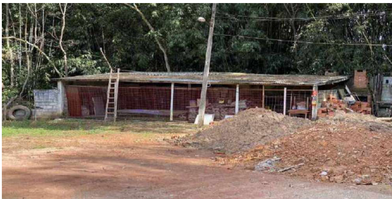
VISTA DEPÓSITO PRÓXIMO BARRACAS DO LAGOS
