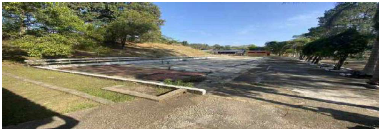
VISTA ESTACIONAMENTO - ANTIGA EDIFICAÇÃO DA LANCHONETE
