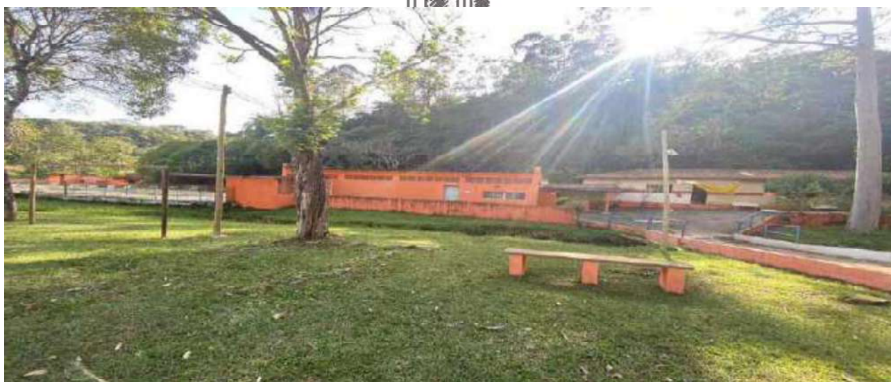
VISTA RESTAURANTE DA PISCINA/VESTIÁRIOS E BANHEIROS
