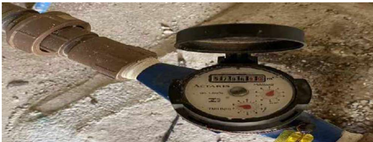
VISTA HIDROMETRO POÇO ARTESIANO
