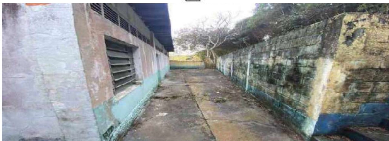
VISTA ANTIGO RESTAURANTE DA PISCINA
