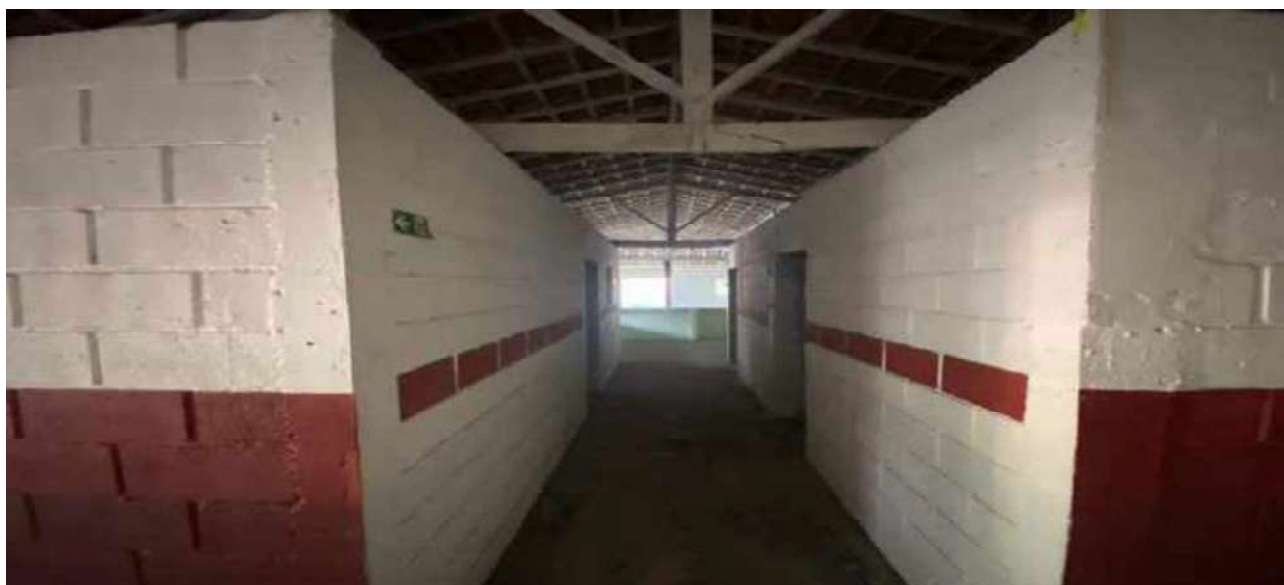
VISTA ANTIGO RESTAURANTE DA PISCINA
