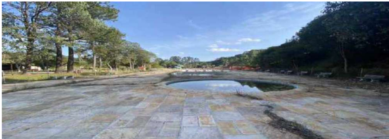
VISTA ÁREA PISCINAS
