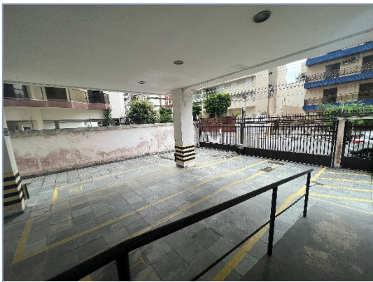
Foto 17 – Vista do acesso ao hall social/elevador
