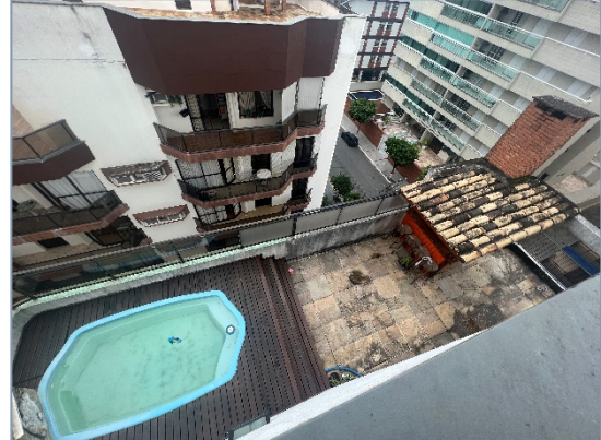
Foto 8 – Vista do solarium com piscina e churrasqueira do apartamento avaliando
