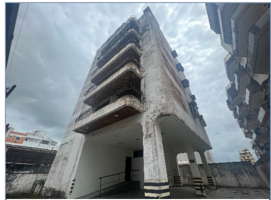
Foto 18 – Fachada do Edifício
