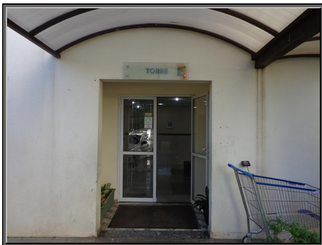
Vista da entrada da Torre E do Condomínio Residencial Be Life.
