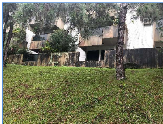
Foto 8 – Vista externa do imóvel avaliando
