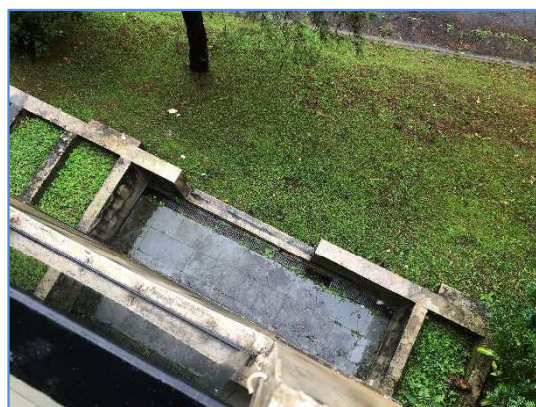
Foto 10 – Vista do terraço térreo do imóvel avaliando
