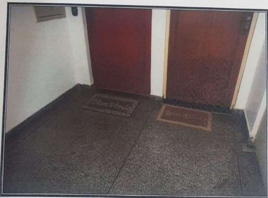
Vista parcial do hall dos andares.
