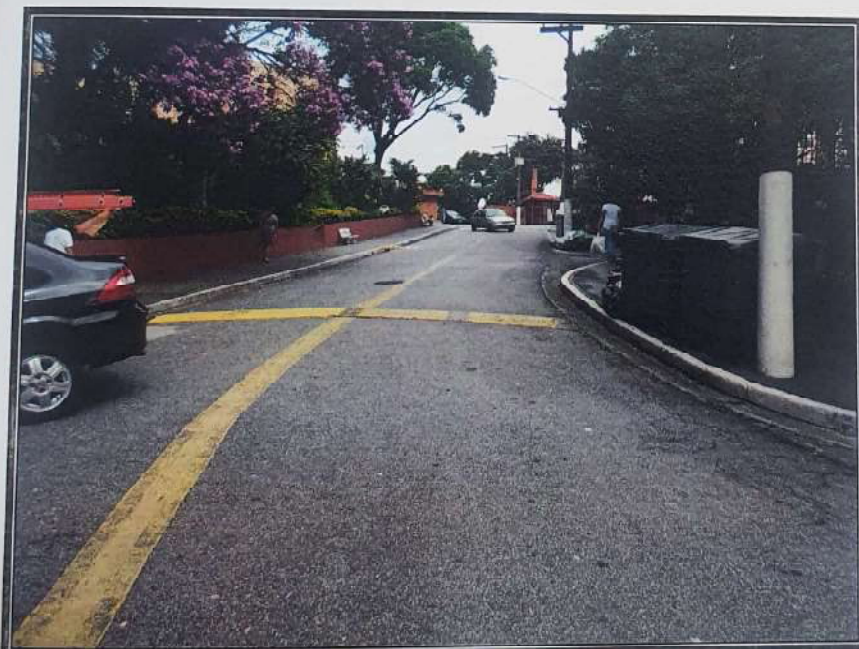
Via interna do Condomínio Residencial Jardim Tropical.
