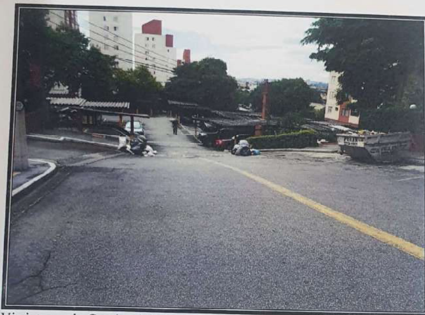
Via interna do Condomínio Residencial Jardim Tropical.
