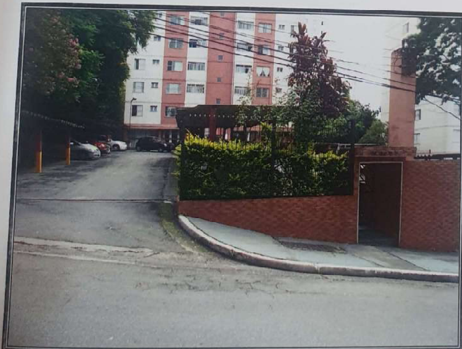
Vista parcial da entrada do Bloco 03.
