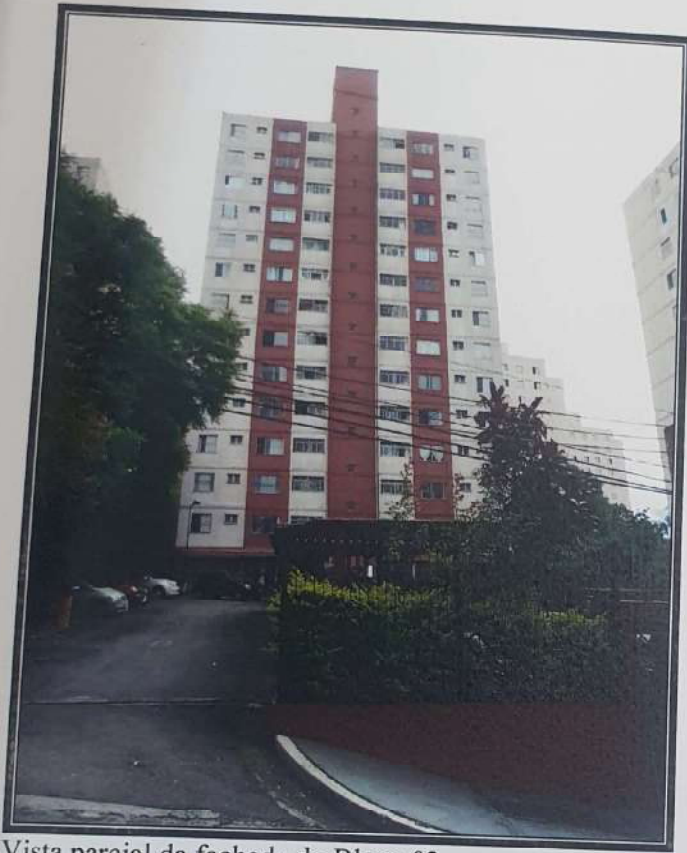
Vista parcial da fachada do Bloco 03.
