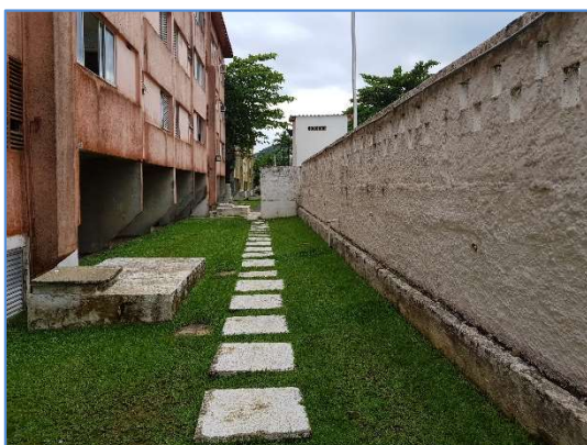
Foto 9 – Vista da área comum do Condomínio
