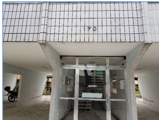
Foto 2 – Vista da entrada do Edifício Hortênsias
