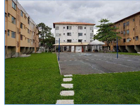
Foto 6 – Vista da área comum do Condomínio e Ed. Hortênsias ao fundo
