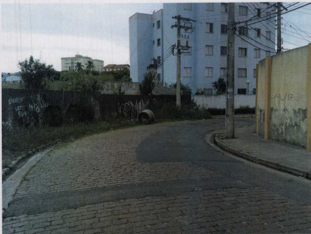
FOTO 2: OUTRA VISTA DA RUA SERRANA EM SENTIDO CONTRÁRIO.
