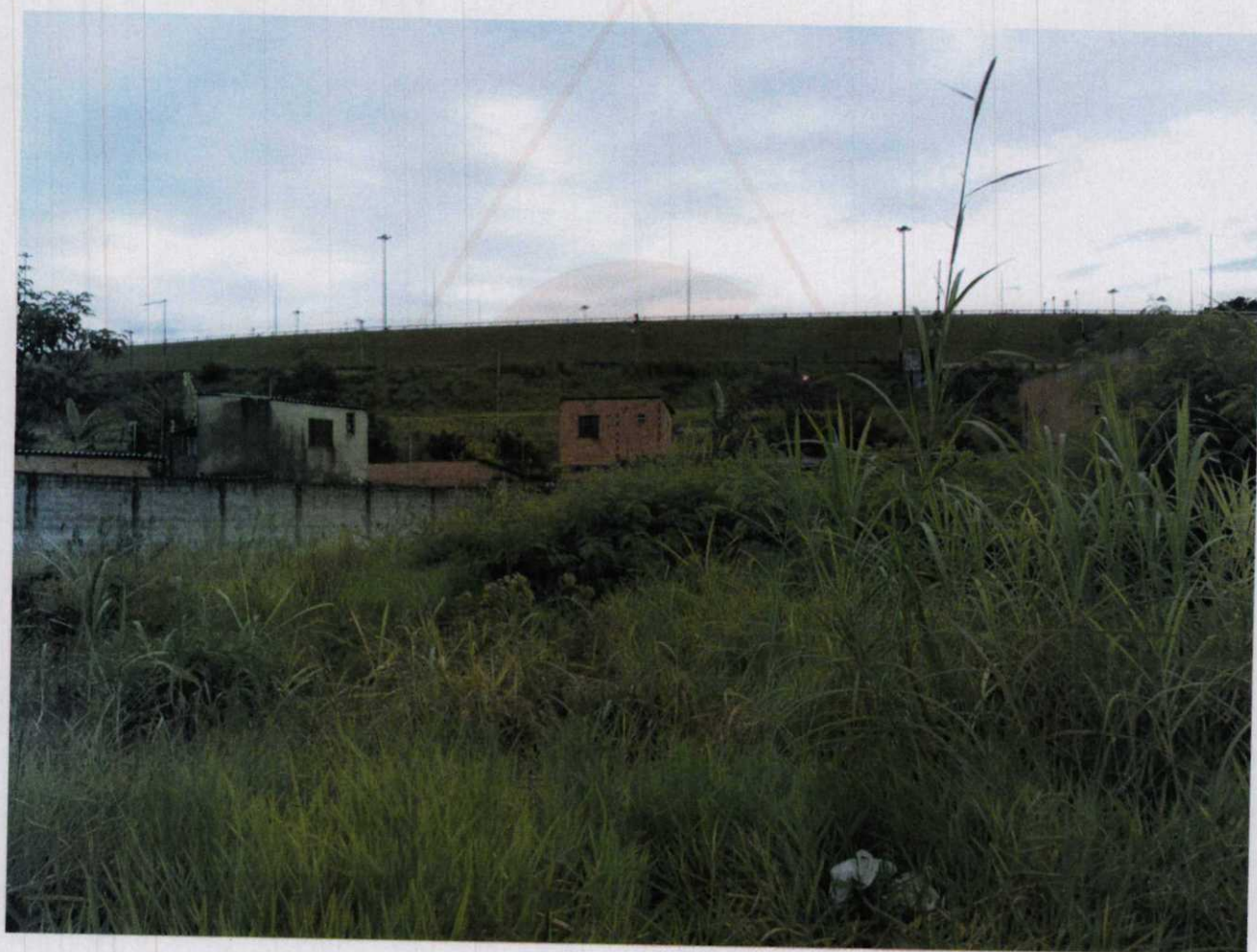
FOTO 15: VISTA PARCIAL DO TERRENO EM DIREÇÃO A LATERAL ESQUERDA.
