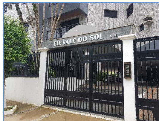
Foto 10 – Vista da fachada do Edifício Vale do Sol
