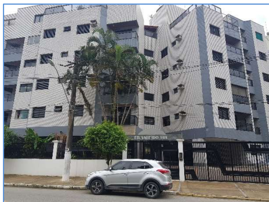
Foto 9 – Vista da fachada do Edifício Vale do Sol
