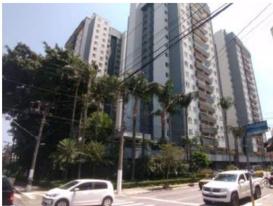
VISTA DA FACHADA DO CONDOMÍNIO ONDE SE LOCALIZA A UNIDADE AVALIANDA.
