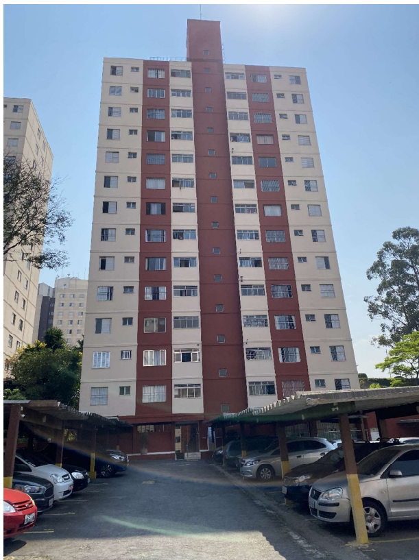
ASPECTOS GERAIS EDIFICIO
